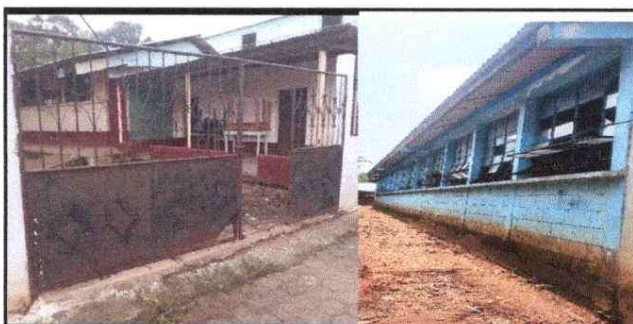
Foto 6: MODULO 4 PORTON: Sustitución de portón de metal Y pared a pintar.
