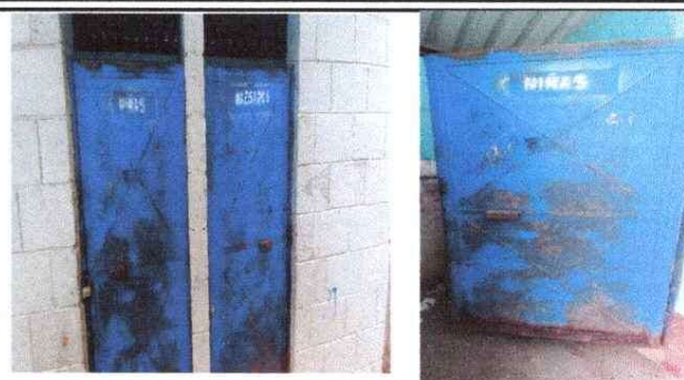
Foto 2: MODULO 2 BAÑO 1: Sustitución de puertas en servicios sanitarios
