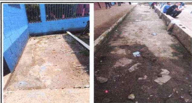
Foto1: MODULO 1 PATIO: Reparación de Planchas de concreto de patio
