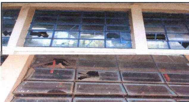
Foto 5: MODULO 3 AULAS: Sustitución de vidrios y ventanas
