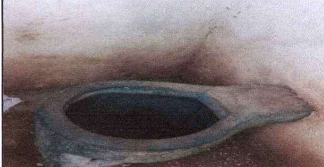
Foto 4: MODULO 2 BAÑO 1: Sustitución Inodoro
