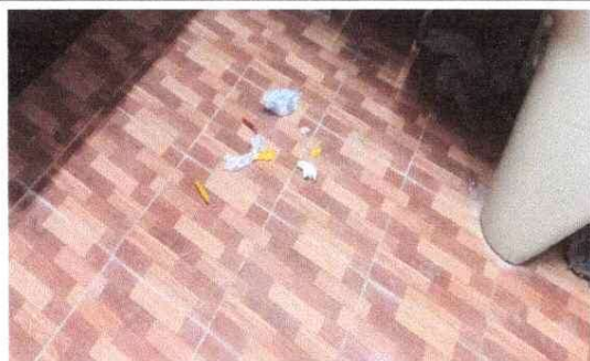
Foto 3: MODULO 2 BAÑO 1: Sustitución de piso cerámico
