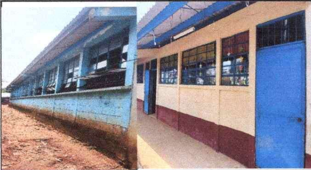
Foto1 paredes a pintar de modulo 1 parte exteriores
